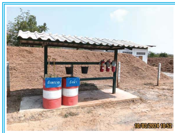
รูปที่ 3-36 อุปกรณ์ดับเพลิงบริเวณสถานที่เก็บวัตถุระเบิด
